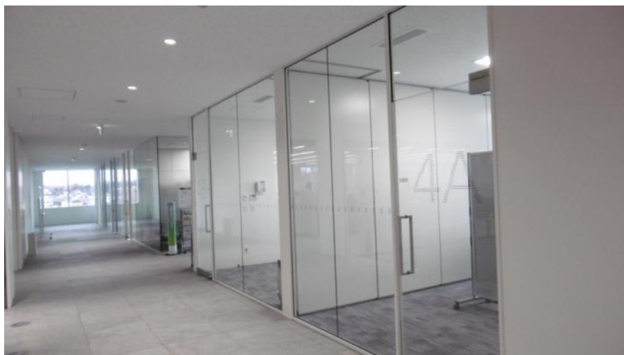
<可動間仕切りを活用した会議室（北広島市役所）>
